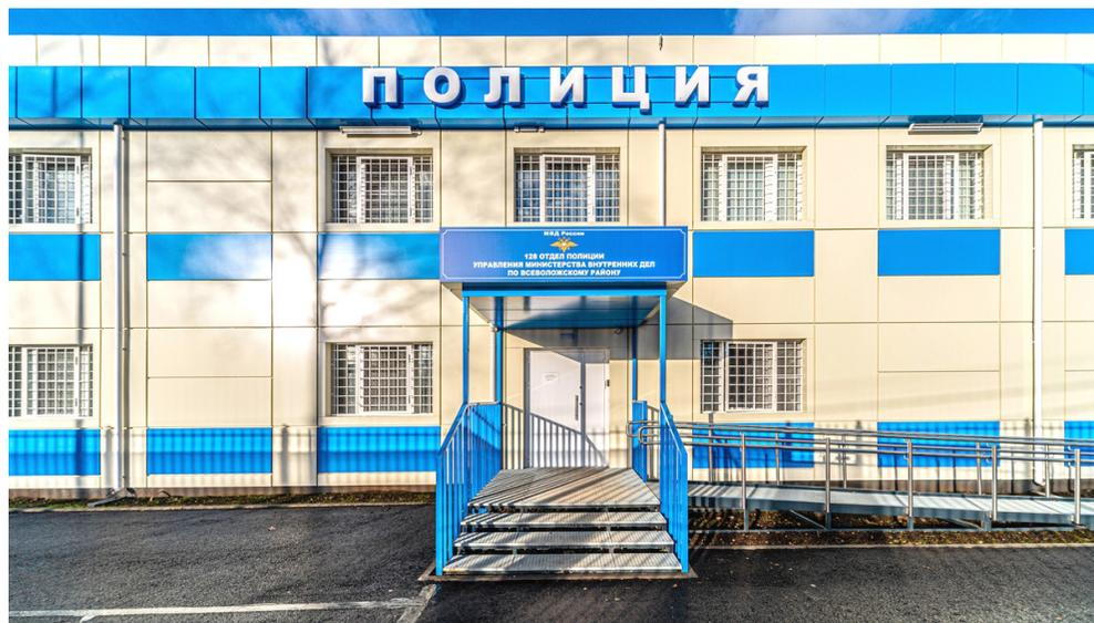
Естественно, модульные постройки имеют ряд отличий от капитальных зданий и помимо перечисленных выше. Давайте сравним их. Так, например, высота «чистого» потолка в модульном строении не может превышать 3,2 м, а длина одного блока – не более 14 м. При этом площадь одного модуля ограничена площадью в 50 квадратных метров. Поэтому такой формат не подходит для постройки складского комплекса, гаража для спецтехники или, например, спортивного зала.
